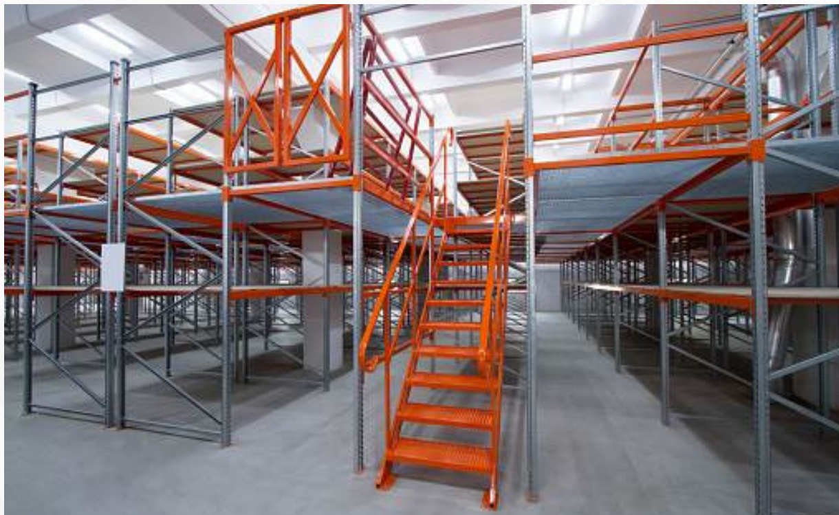
Structure métallique et mezzanine
