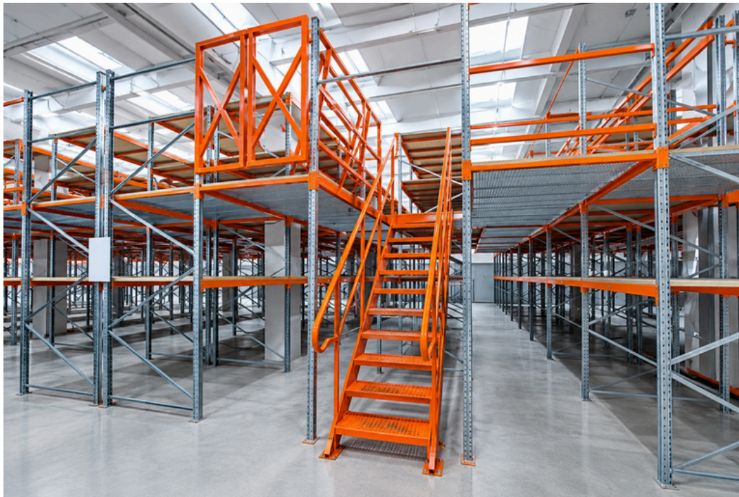
Structure métallique mezzanine
